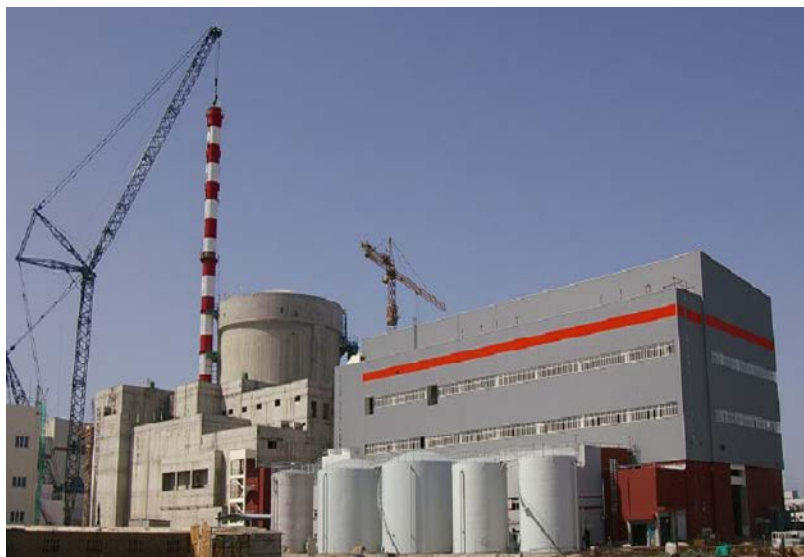
中国在巴基斯坦最大承包项目——已投入运营的恰希玛核电站一期和二期
